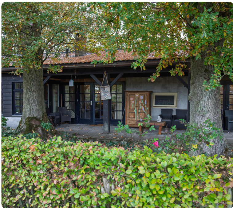
Auf diesem Pflegehof wurde ein Bestandsgebäude aus dem 19. Jahrhundert in eine WG umgebaut.
